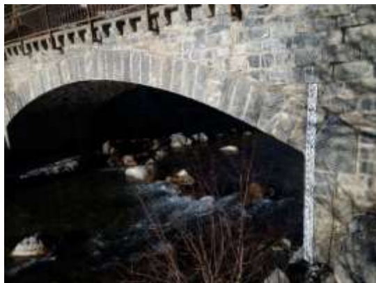
Échelle posée au pont du Peynin sur la commune d'Aiguilles et fabrication de repères en lave émaillée avec deux couleurs pour dissocier les niveaux atteints par les eaux au bord de cours d'eau (en bleu) et les niveaux atteints par les crues sur les cônes de déjection (en rose)
